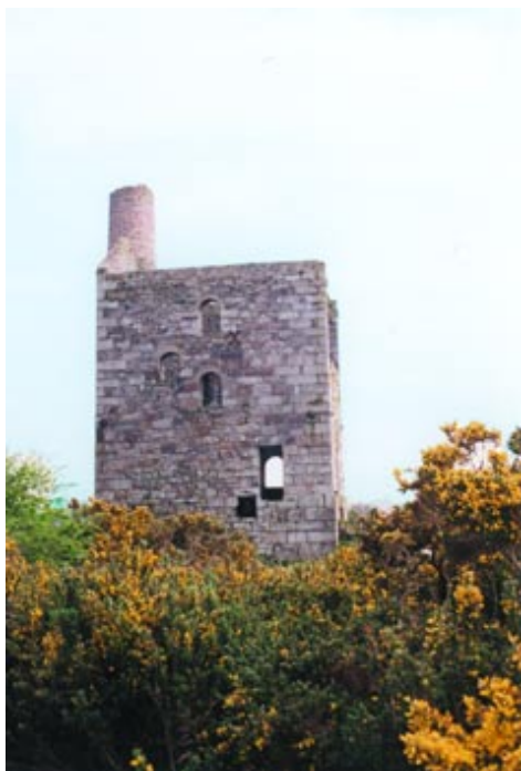
Una "engine house"
