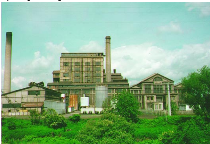
Montceau-les-Mines: le vecchie centrali termoelettriche
