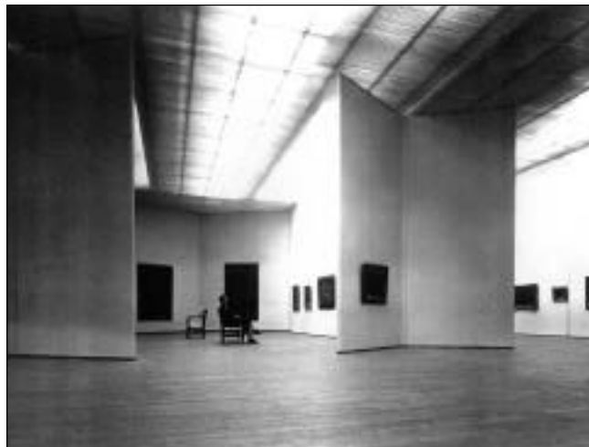
Figura 4. Milano, Padiglione d'Arte Contemporanea. Veduta parziale degli spazi destinati alla pittura; sono visibili il lucernario orientabile secondo il sistema Saeger e le pareti mobili che ripartiscono l'open space in cinque ambienti di forma esagonale. Milano, Civico Archivio Fotografico, foto Mario Perotti (n. inv. 1628). Tutti i diritti riservati.
